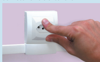
Encaixar a tampa à base do mecanismo
