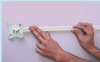
Medir para cortar a base da canaleta e fixá-la
