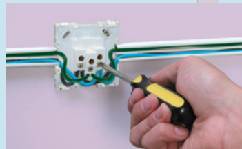
Passar os fios na canaleta e conectá-los ao mecanismo
