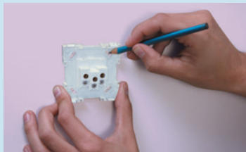
Definir o ponto, marcar, fazer a furação e fixar o mecanismo
