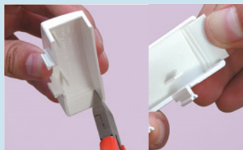
Remover o pré-corte do acoplador
